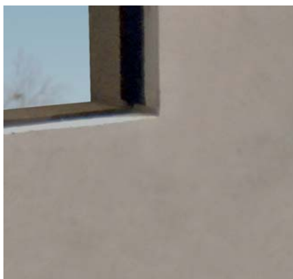
Sandwichvägg med fasad med slät yta
