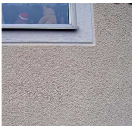
Fasad med stöpplad yta och släta partier runt fönstret
