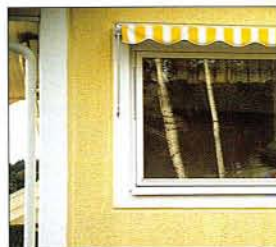
Väggar ovan mark kan levereras som tilltillval med borstad yta och släta partier runt fönster, dörrar och i hörn.
